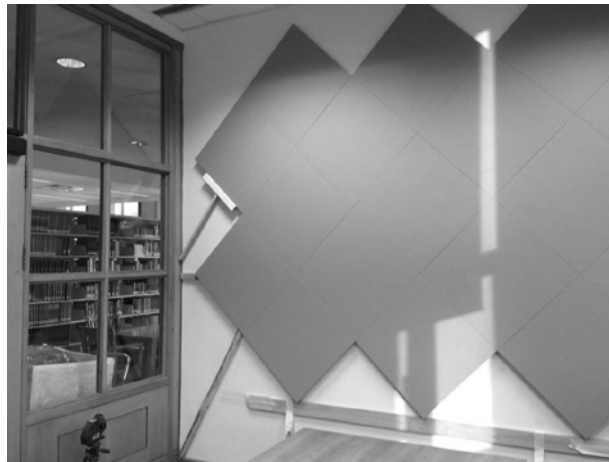
Resim 16. SKK Grup Çalışma Odası Ses Yalıtımı Çalışması
