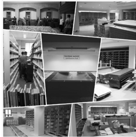
Resim 10. SKK Kompakt Raf Sistemi İnşaat Aşamaları
